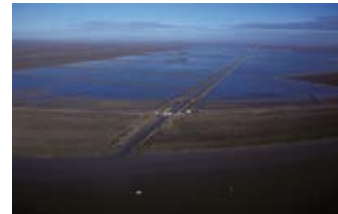
Vista aérea desde la toma de agua.
